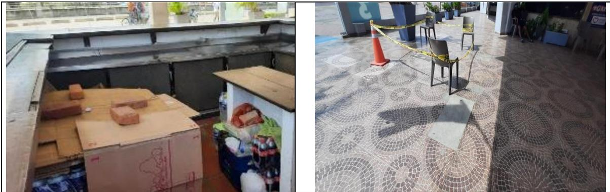
Área de Cafetería. Se evidencian fracturas y desgaste en la cerámica instalada y deterioro de mesón de la cafetería.
