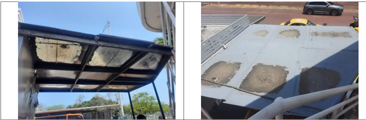
Estructura entrada puerta No.2
